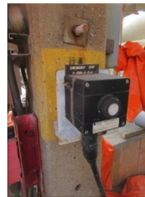
รูปที่ 2-32 ระบบหยุดสูบล้างฉุกเฉินทั้งระบบ บริเวณถังจัดเก็บ
