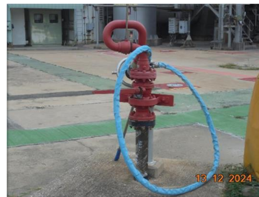
รูปที่ 2-40 หัวฉีดน้ำและโฟมดับเพลิงระยะไกล
