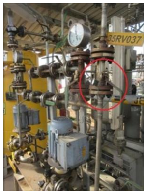
รูปที่ 2-35 Lock-out Mercaptan Injection Pump
