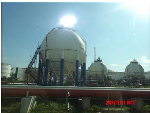
รูปที่ 2-27 ถังเก็บกากปิโตรเลียมเหลว
