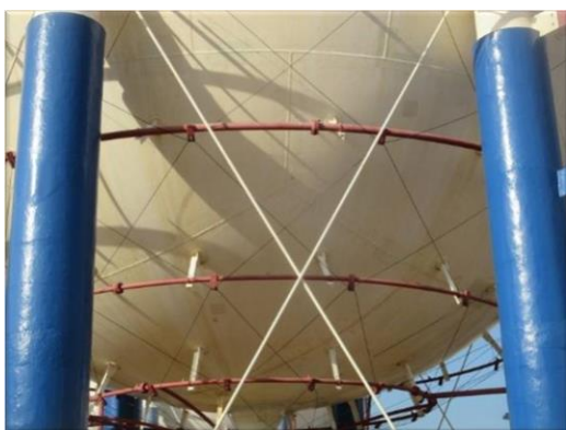
รูปที่ 2-25 Fire Detector (Plastic Tube)
